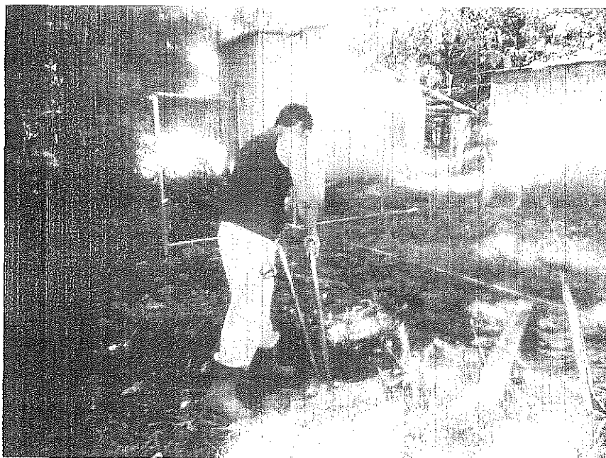
EXCAVACIONES PARA COLOCAR REFUERZOS VERTICALES DE CERCA PERIMETRAL
