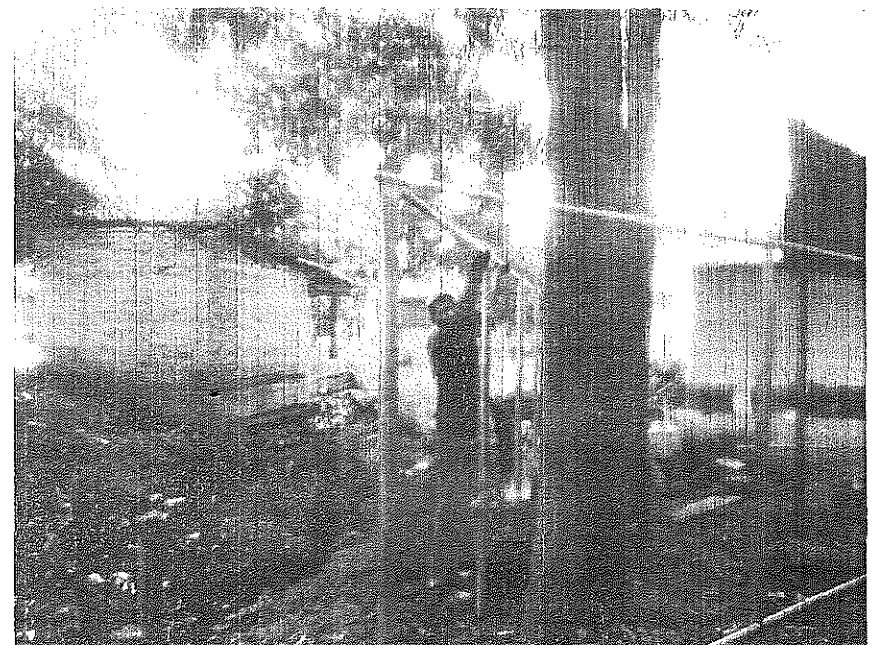
TRABAJOS DE PREPARACION Y COLOCACION DE REFUERZO HORIZONTAL, TUBO HoGo 1"
