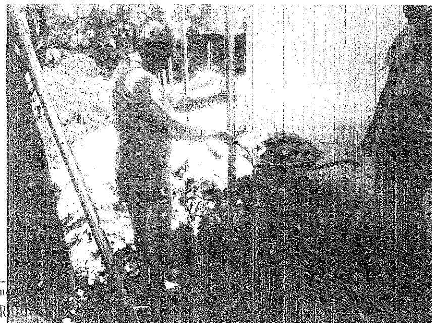
TRABAJOS DE COLOCACION DE REFUERZO VERTICAL PARA MALLA CICLON (TUBO HoGo \phi 2") EN MURO DE MAMPOSTERIA DE PIEDRA
