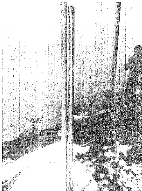
COLOCACION DE REFUERZOS VERTICALES EN CAMBIOS DE NIVELES
