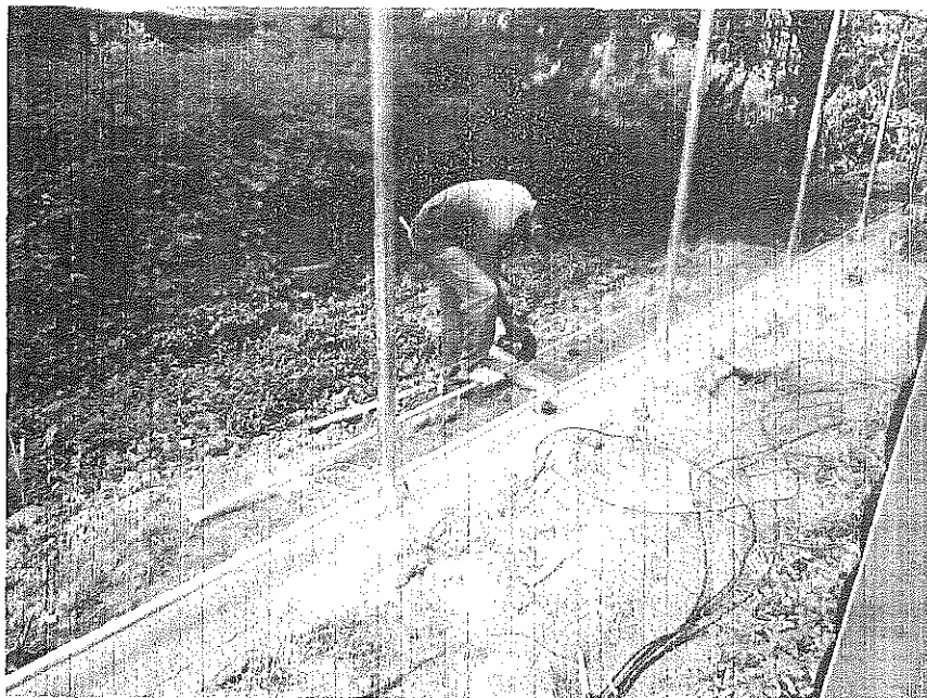
TRABAJOS DE PREPARACION Y COLOCACION DE REFUERZO HORIZONTAL, TUBO H6G6 1"
