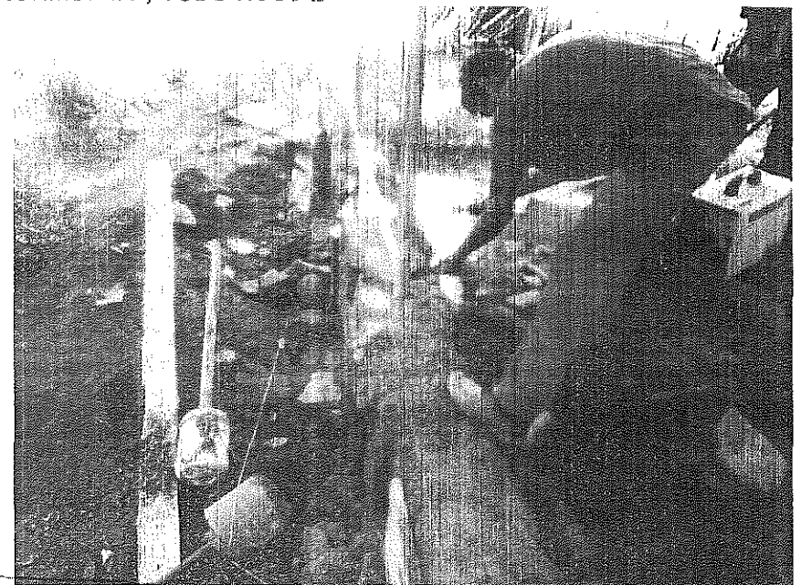
TRABAJOS DE PREPARACION Y COLOCACION DE REFUERZO HORIZONTAL, TUBO HoGo 1"
