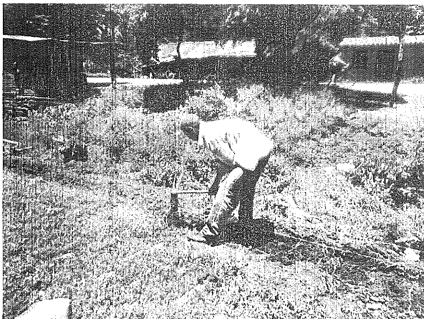
TRABAJOS DE EXCAVACION PARA MURO DE MAMPOSTERIA
