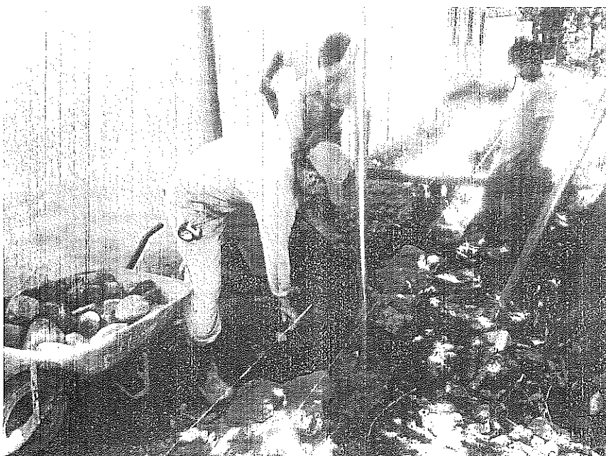
TRABAJOS DE COLOCACION DE REFUERZO VERTICAL PARA MALLA CICLON (TUBO HoGo \phi 2") EN MURO DE MAMPOSTERIA DE PIEDRA
